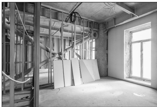
Slika 1: Konstrukcija gips kartonskih ploča (izvor: internet)
